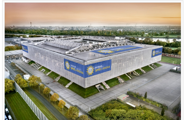
Die Nordseite der Merkur Spiel-Arena (Oktober 2021)
