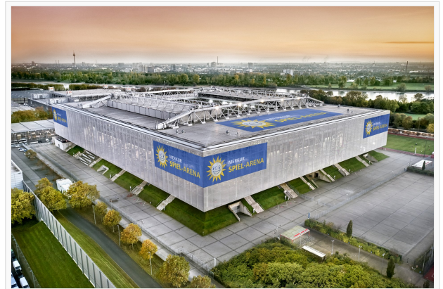
Die Nordseite der Merkur Spiel-Arena (Oktober 2021)
