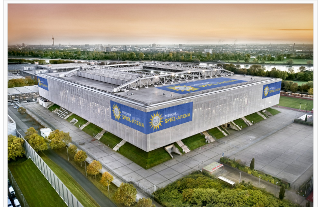
Die Nordseite der Merkur Spiel-Arena (Oktober 2021)
