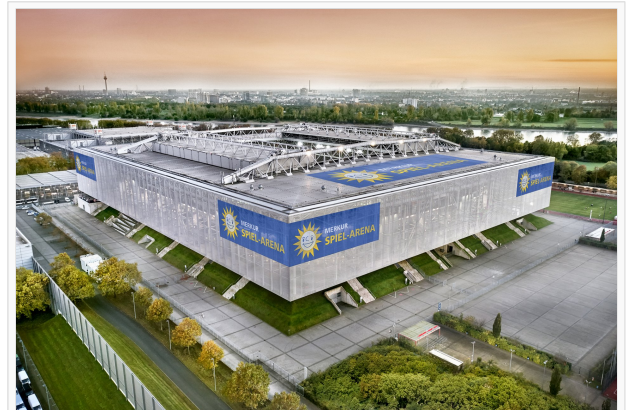
Die Nordseite der Merkur Spiel-Arena (Oktober 2021)
